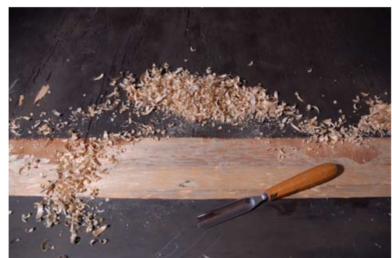
Inv.-Nr. 119: Abnahme der Querleisten
